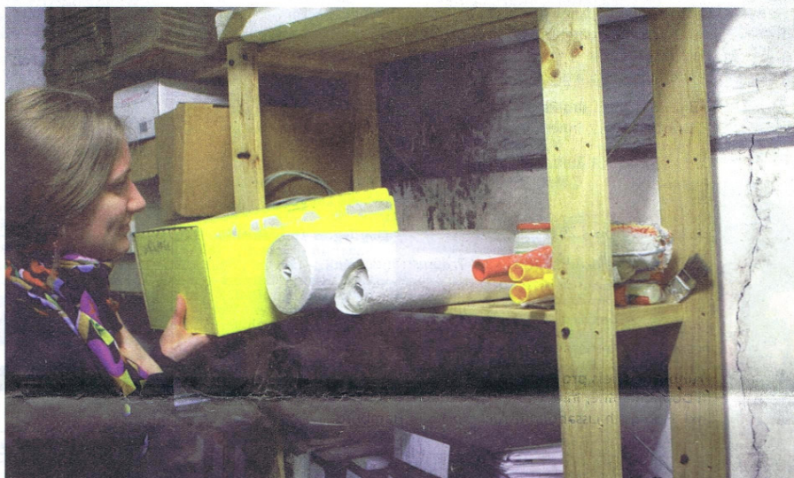
Wenn Wasser in den Keller dringt, kann sich als Folge davon Schimmel in der Wand bilden. Foto Saint-Gobain
